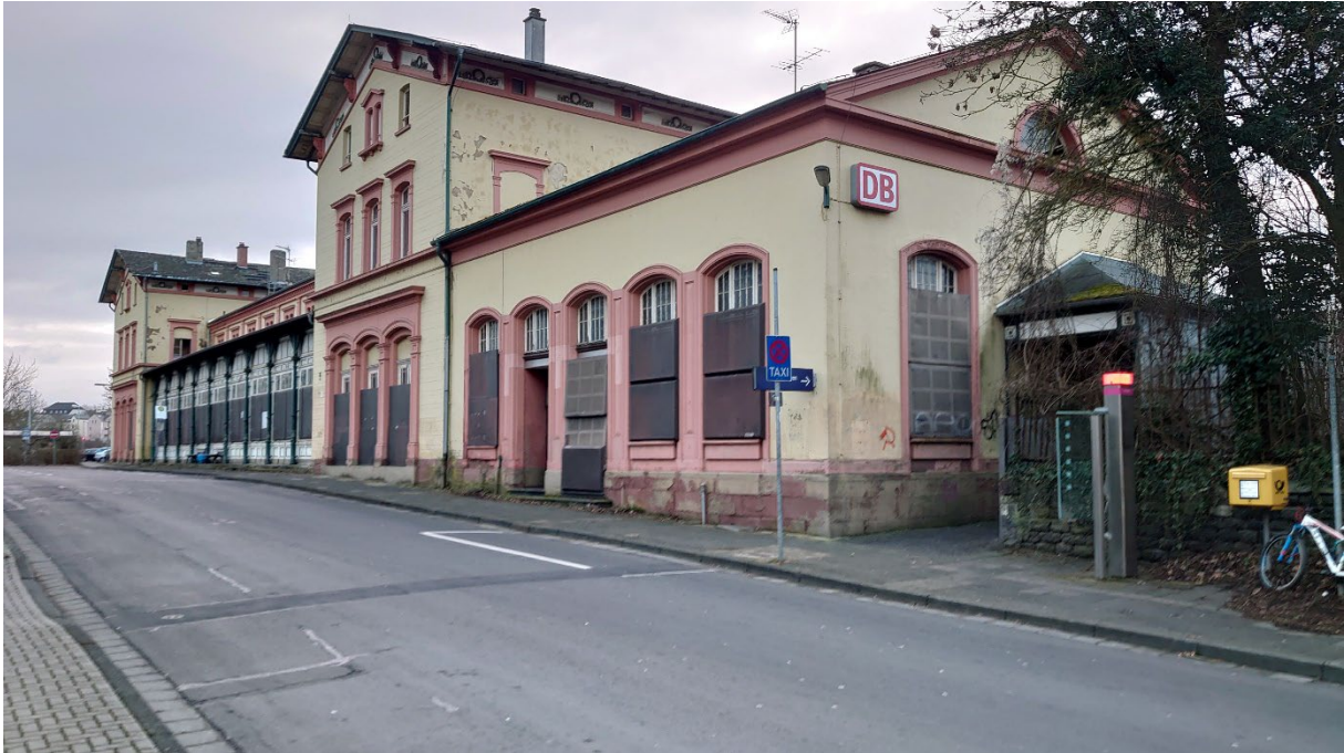
Abb. 15: Ansicht des Bahnhofsgebäudes in Diez von der Straße
