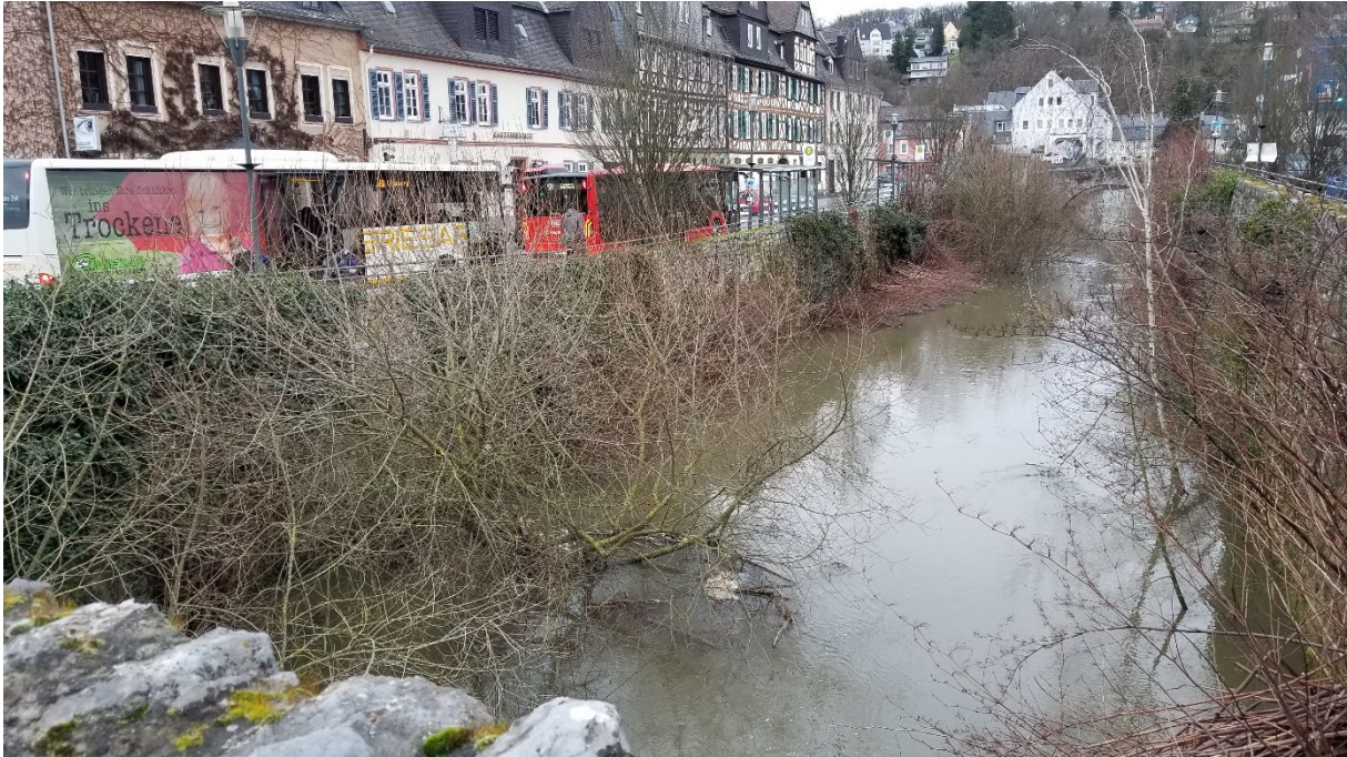
Abb. 17: Uferbereich Aar auf der Höhe des Marktplatzes
