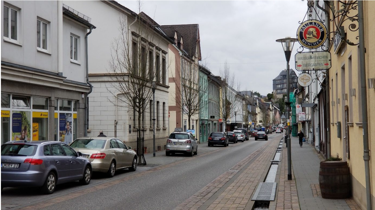
Abb. 9: Blick in die Wilhelmstraße
